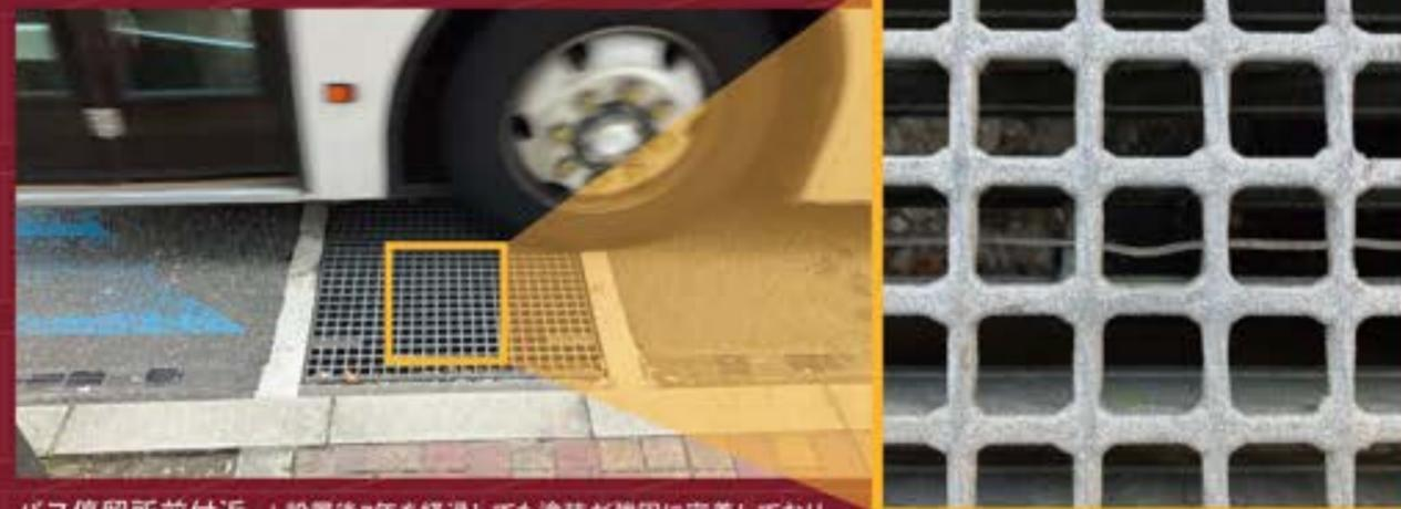
バス停留所前付近 | 設置後7年を経過しても塗装が強固に密着しており、目立った摩耗もなく滑り止め効果を発揮している。
