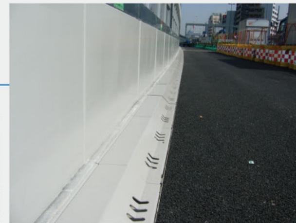
4 高強度ステンレスロックピン式【跳ね上がり防止鉄蓋】
