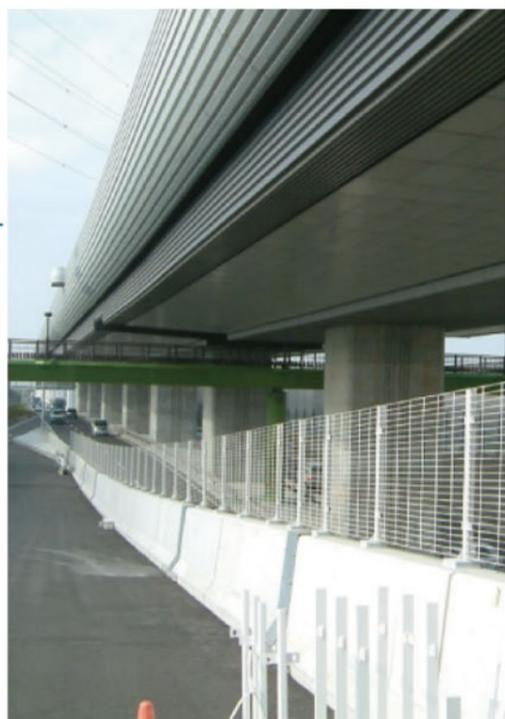
3 壁高欄・鋼製排水溝
