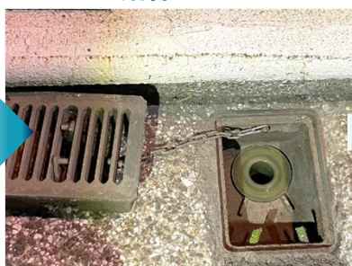
GFRP製定着部の固定状況
